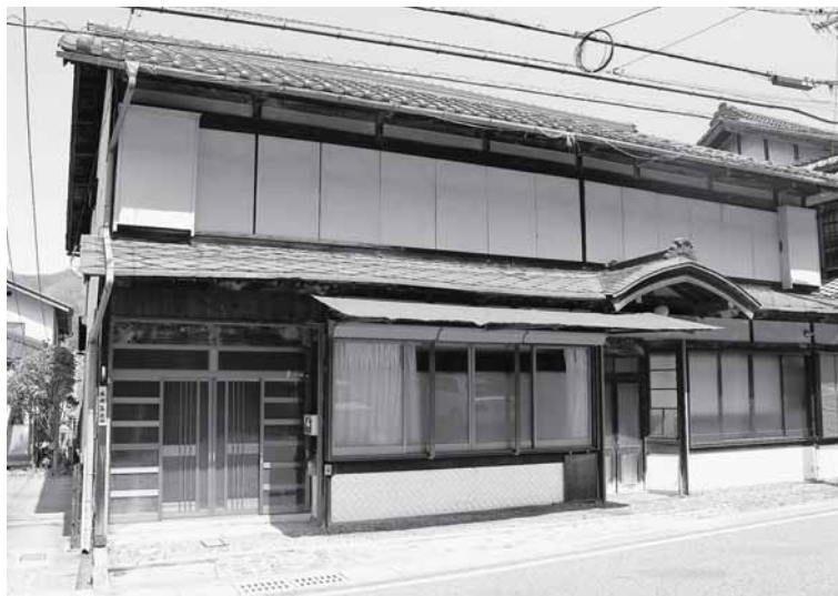
空き家の活用（須原本町集会所）
