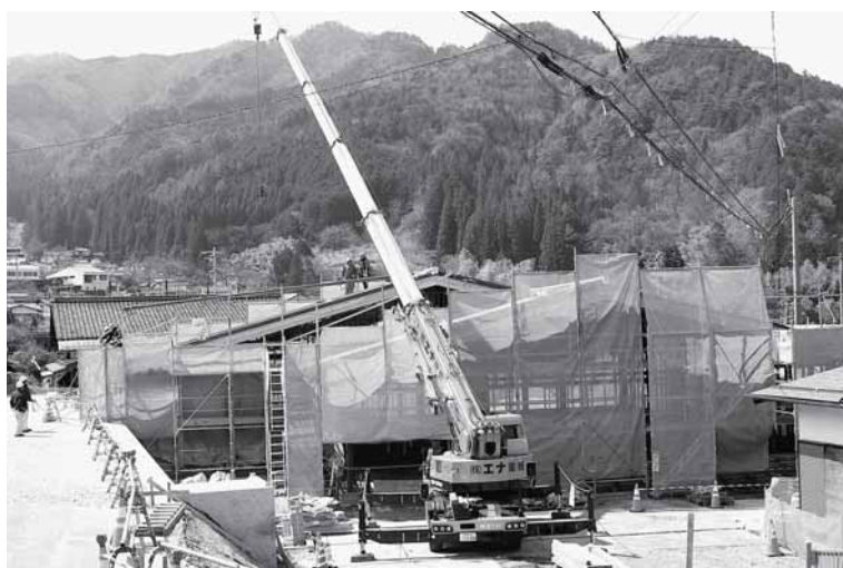
J A 木曾大桑支所移転工事
