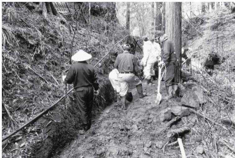
中山間地域等直接支払制度交付金事業（長野西部地区水路整備）
