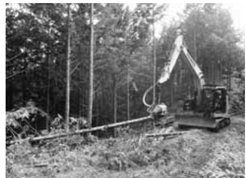
重機による森林施業
