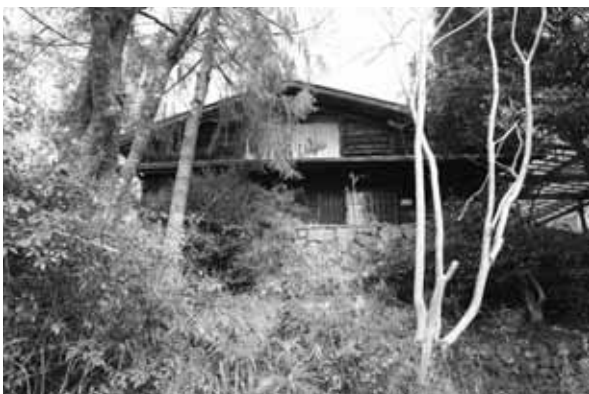
村内の空き家の様子
