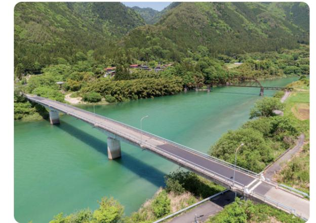
今年度も昨年度に引き続き車道の工事となります。床版の劣化(舗装下コンクリート)が進行している為、舗装版の撤去後、補修箇所を選定し、床版の補修を行います。
